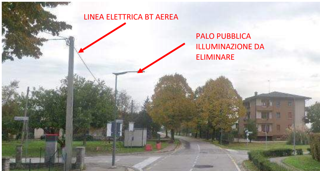
Inizio area delle lavorazioni provenienza Levada
